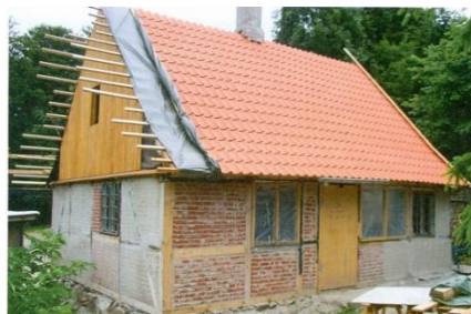
Beværrerhuset under renoveringen i 2004
